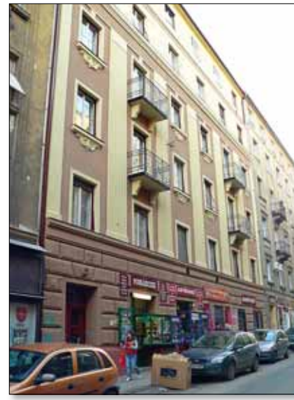
Márvány utca 44. – önkormányzati támogatással felújított homlokzat
