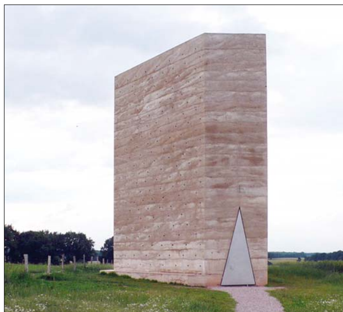
A Bruder Klaus-kápolna kívülről szigorú betontömbnek látszik
