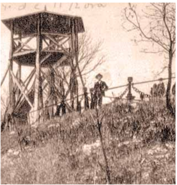
A glorieta megépítése nagy előrelépésnek számított
