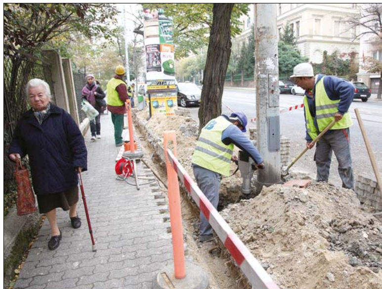
A közvilágítási kábeleket újítják fel a Böszörményi úton
