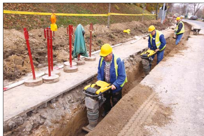
A Németvölgyi úton több szakaszon is zajlik a munka
