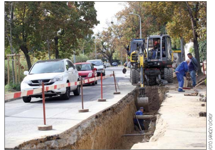
Október végéig nehezebb a közlekedés a Németvölgyi út felső részén
