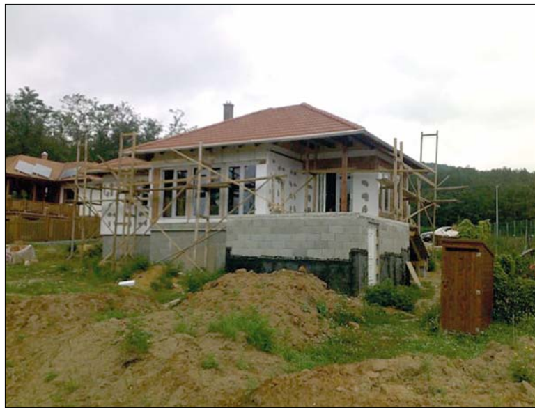
Épülő passzívház: vastag hőszigetelés a falakon, speciális ablakok
