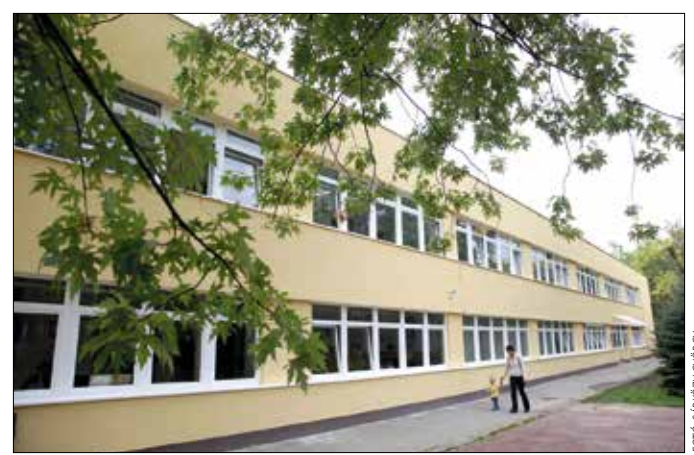
Szigetelték az épület homlokzatát, és új nyílászárókat szereltek be
