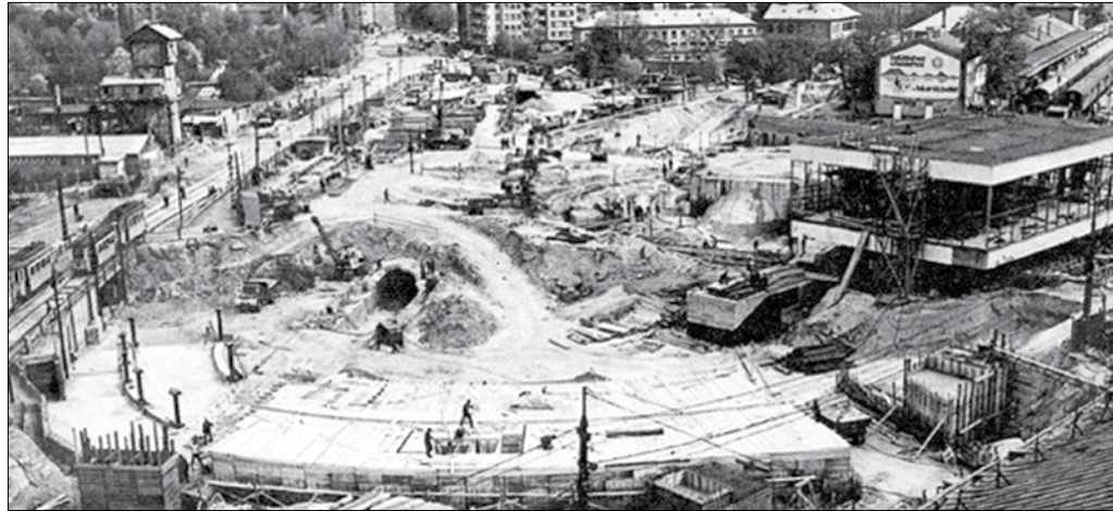
A Déli pályaudvar építése, közepén az Ördögárok (1972)
