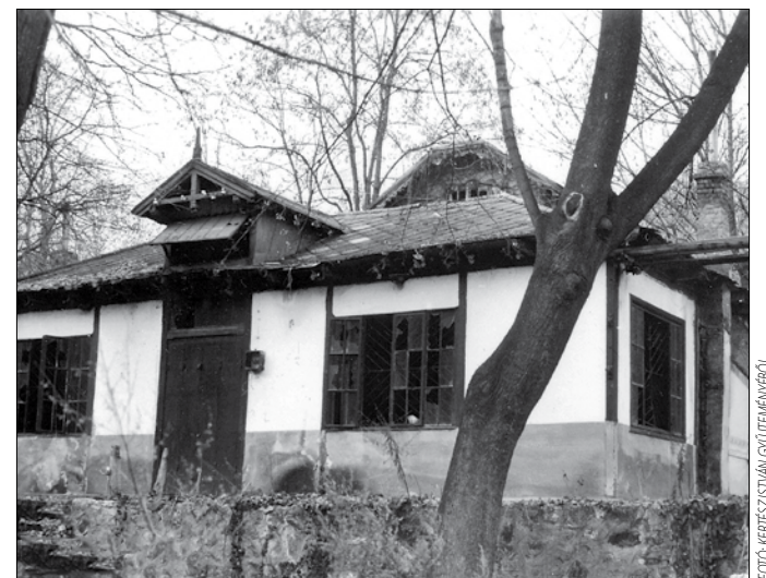
Az Ördögórom csárda épülete
