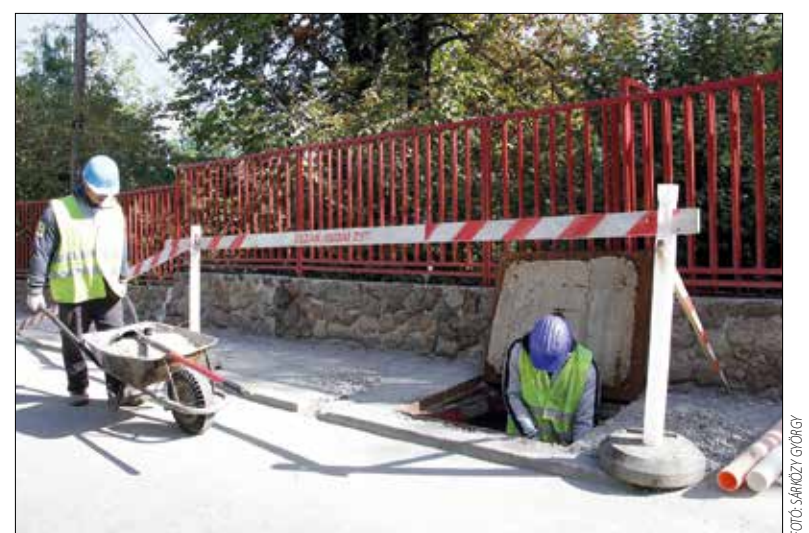
Járdafelújítás a Cinege úton
