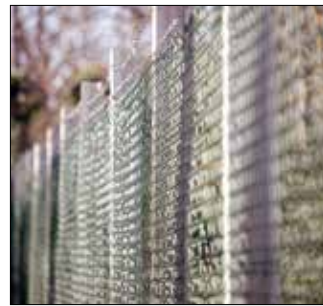
Jobb, ha a telekszomszédok békésen beszélnek meg problémáikat
