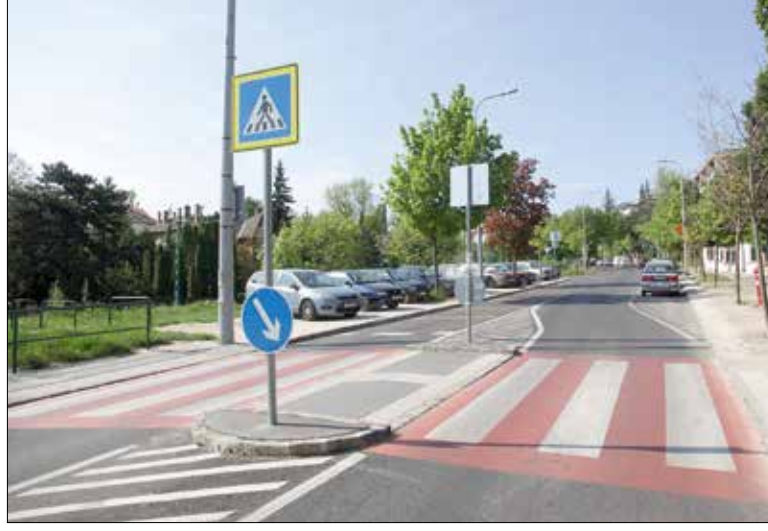
Véget ért a Németvölgyi út önkormányzati fenntartású szakaszának teljes felújítása
