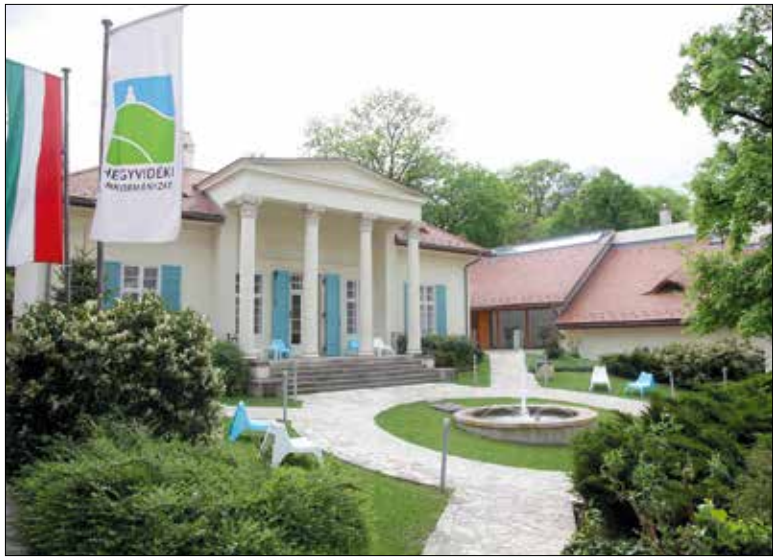
A gyönyörű épületet és környezetét újra „fel kell fedezniük” a látogatóknak
