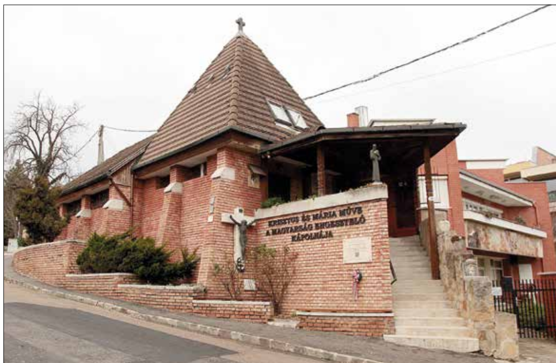
Együtt kezdték el és fejezték is be Regőczy István atyával a Kútvolgyi Szűz Mária Engesztelő Kápolna bővítését, építését
