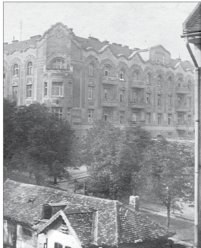
A család 1909-ben költözött a Kék Golyó utcai épületbe
