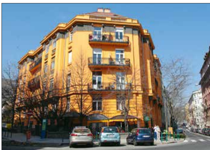
Városképi szempontból fontosak a homlokzati rekonstrukciók
