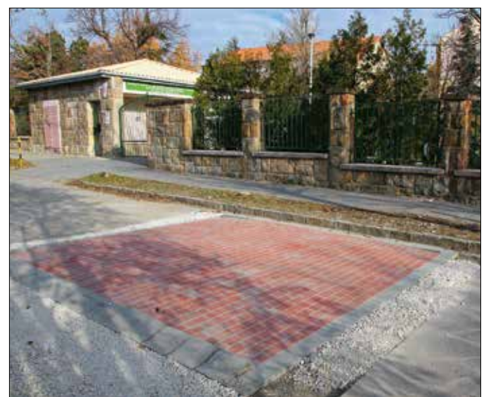
Forgalomcsillapító küszöbök épülnek a Hegyhát úton
