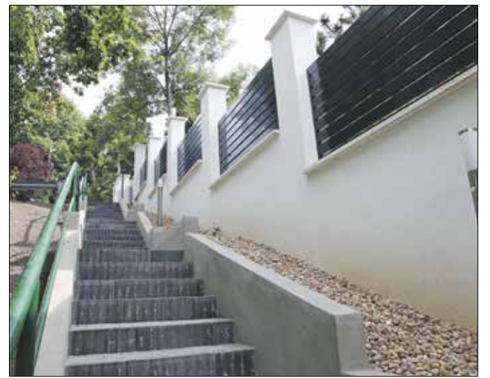
Befejeződött az Ada utcai lépcső felső szakaszának rekonstrukciója
