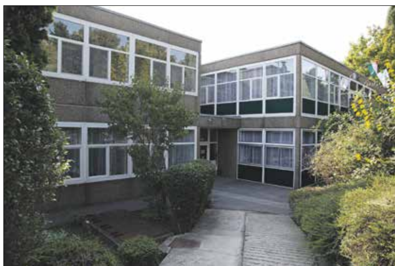
Megkezdődött a Hegyvidéki Mesevár Óvoda nyílászáróinak cseréje
