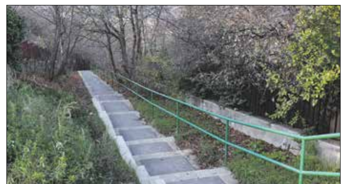
Elkészült az Istenhegyi lejtő lépcsős járdájának részleges átépítése
