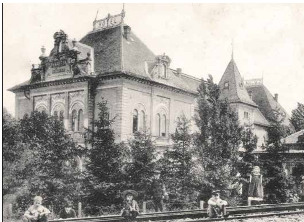
Az egykor országserte híres, sokak által látogatott Svábhegyi Nagyszálló épülete is komoly érték
