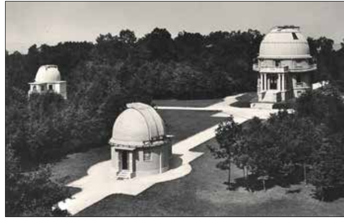
A csillagvizsgáló kupolás épületei (1936)
