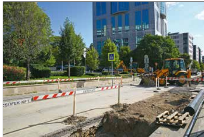
Vízvezeték-felújítás a Csörsz utcában
