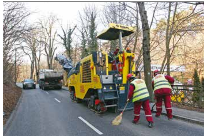
Betontisztítás speciális marási technikával a Zugligeti úton
