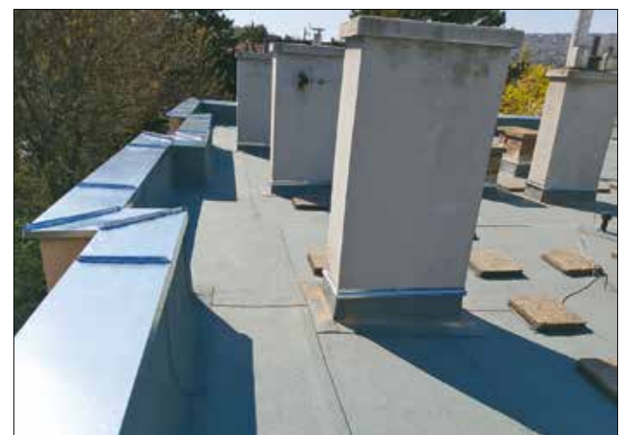
A tető szigetelésével megszűnt a beázás a Hegyalja út 136–138.-ban
