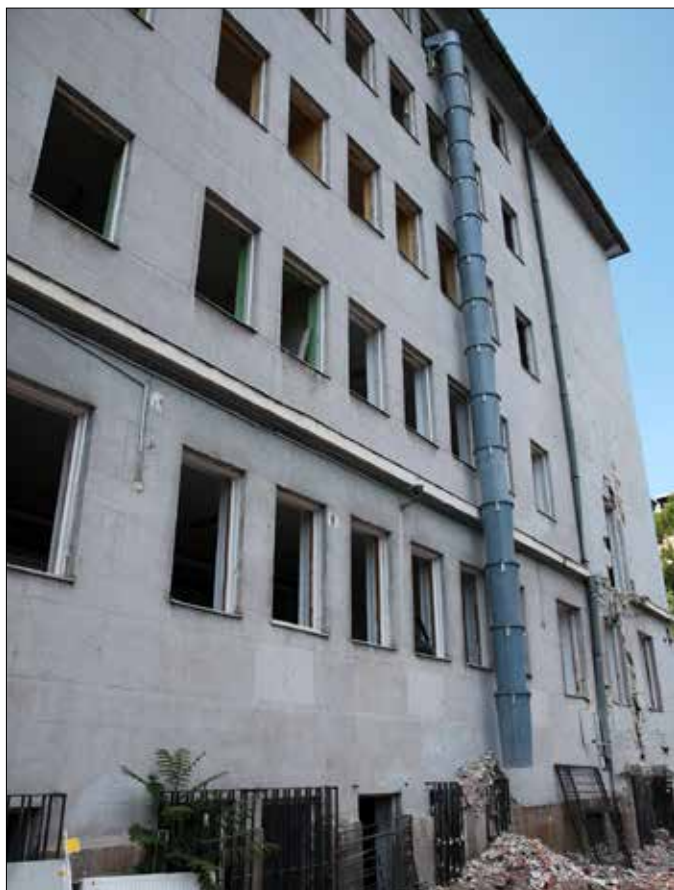
Zárt csúszdán jut le a törmelék az udvarra
