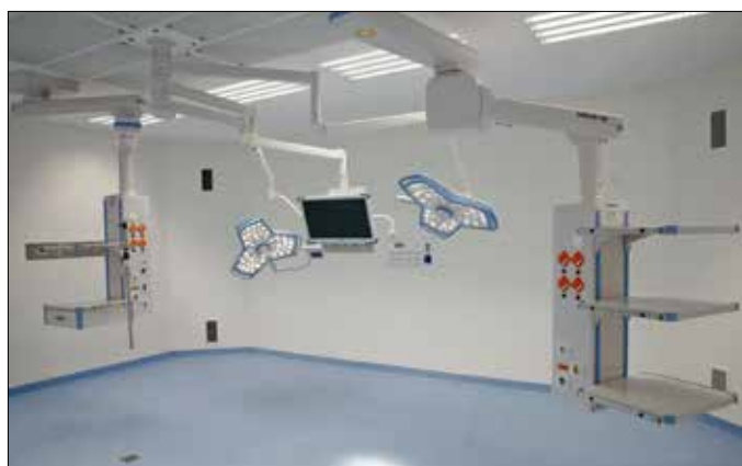
Öt új, modern műtő is helyet kapott a felújított épületben
