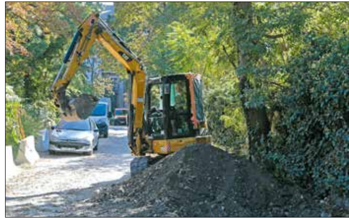
A földút helyett szilárd burkolat készül, kiépül a közvilágítás, járda és parkoló is lesz a Gyógyfű utca Kék Golyó utca felőli részén
