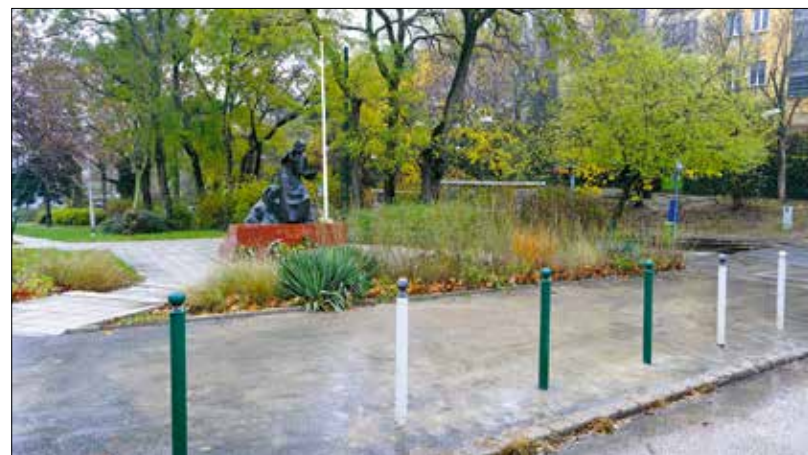
Felújított járdaszakasz az Apor Vilmos téren
