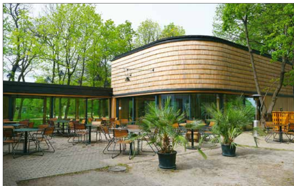
Az új épület formavilágával és materiájával is teljesen új fejezetet teremt a síház környékének jövőjében
