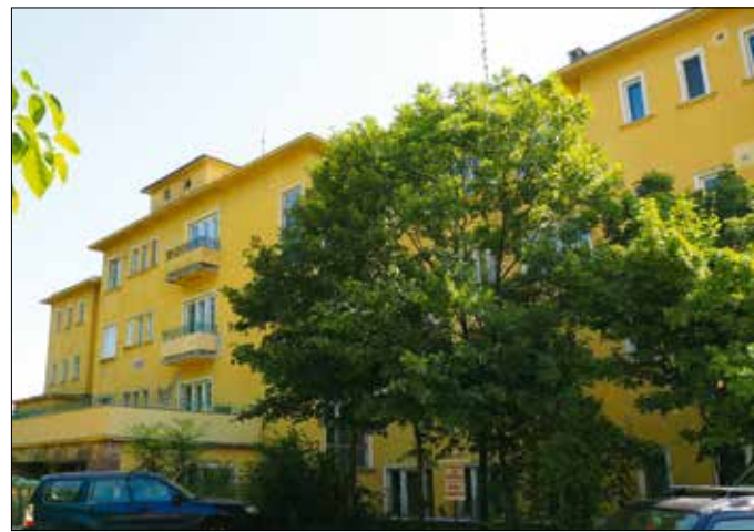
A Melinda út 30–32. alatti ház több eredeti építészeti részlete megújult
