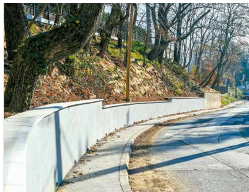
Támfal épült a felújított járdaszakasz mellett a Költő utcában
